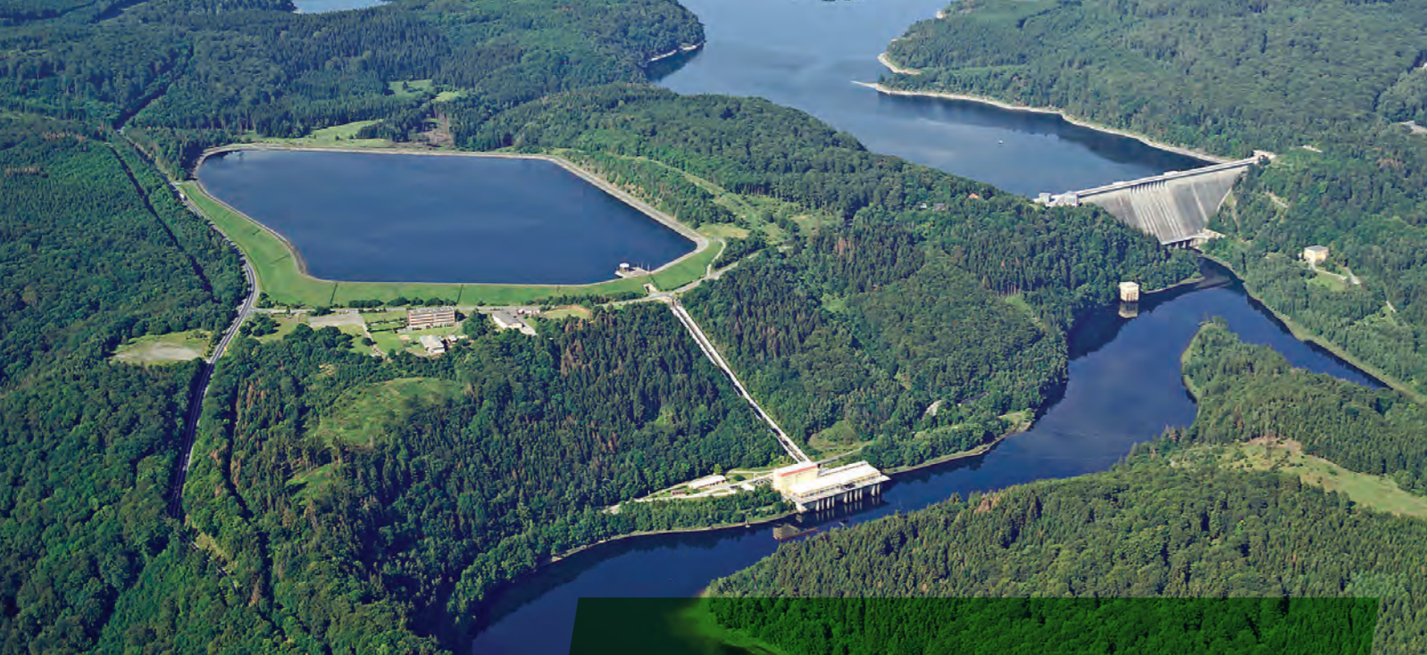
Pumpspeicherkraftwerk und Laufwasserkraftwerk Wendefurth. Das Pumpspeicherkraftwerk mit 76% Wirkungsgrad und 531 MWh Arbeitsvermögen kann 6,5 Stunden lang auf rund 80 MW Vollast laufen, innerhalb von 120 Sekunden fährt es hoch.
