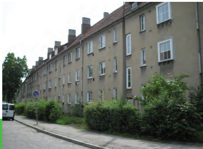
Objekt vor der Sanierung: Dr.-Martin-Luther-Str. 37-49 Kinderstube
