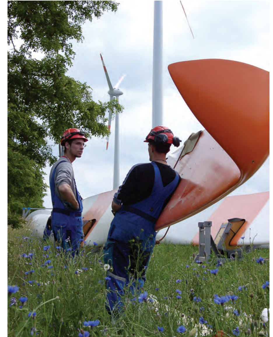
Aufbau von Windenergieanlagen
